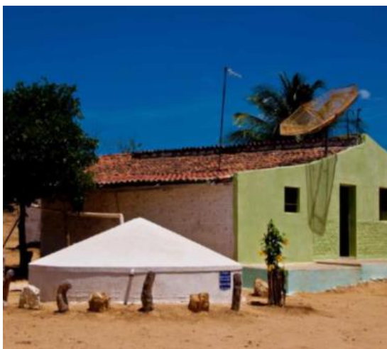
Figura 1 - Cisterna de placas construídas pela ASA Brasil
